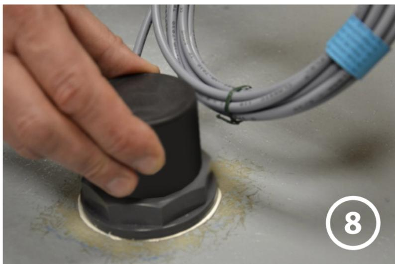
Quando siete sicuri che l'installazione sia perfetta bloccate con un pò di silicone (poche gocce) il trasduttore alla flangia di montaggio in modo che non si sviti con le vibrazioni.
